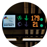
PK-LEVEL pannelli di indirizzamento all'interno del parcheggio
